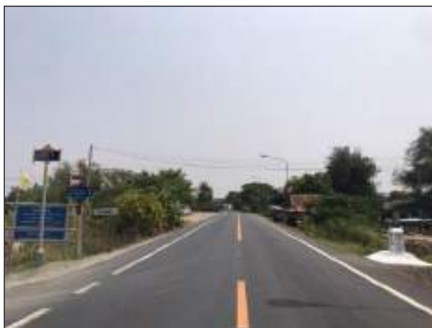
รูปที่ 6-10 ตัวอย่างภาพถ่ายจริงก่อนดำเนินการก่อสร้างและหลังการก่อสร้าง
